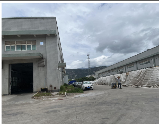
西面--隔兴工大道为京九铁路线
