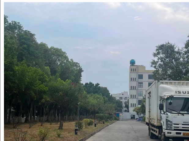
南面-凯源硬质合金股份有限公司厂房
