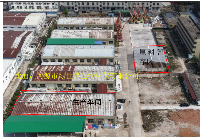
项目北面：工业园内其他厂房，河源市绿世界生物环保科技有限公司
