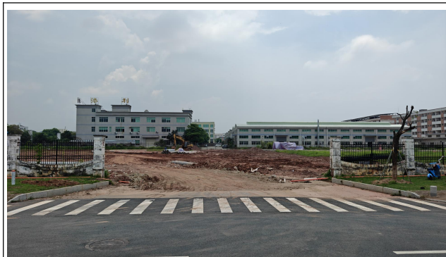
北面-河源市江盛科技股份有限公司、港利实业 国际有限公司厂房
