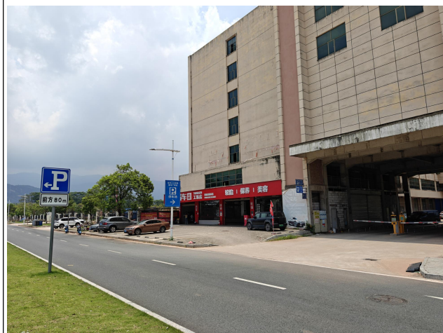
东面--空置厂房及商铺
